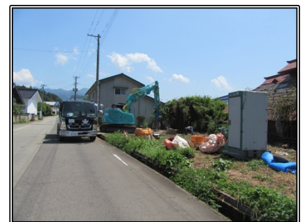
倉庫の解体撤去工事の様子
