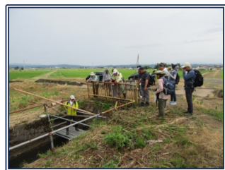
大深沢川と交差する サイホン
